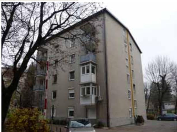
Slika 5 Blok Pr5, obstoječe stanje.
