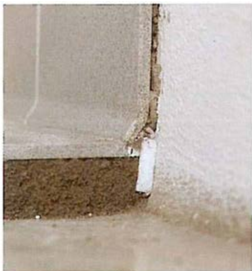
Slika 4: Primer vgradnje dilatacijskih fug s podložnim materialom ob kotnem stiku ob uporabi ustrezne kotne ploščice
