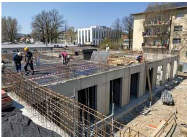
Trenutno stanje izvedbe del na gradbišču Gerbičeva
