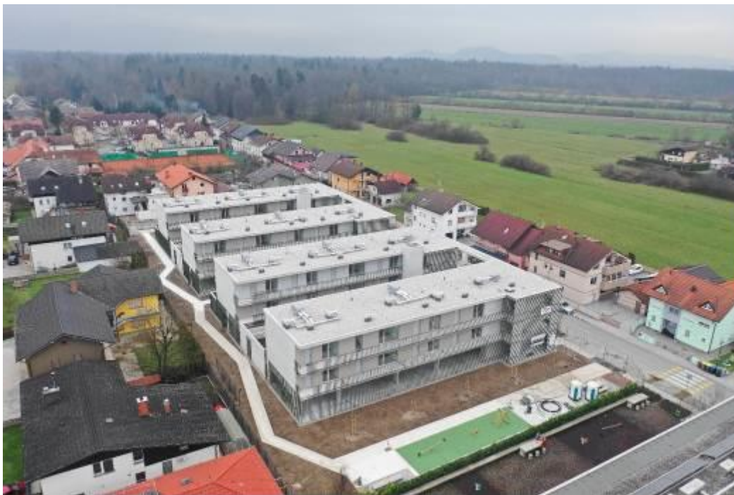
(Ljubljana – Dolgi most, gradnja)
