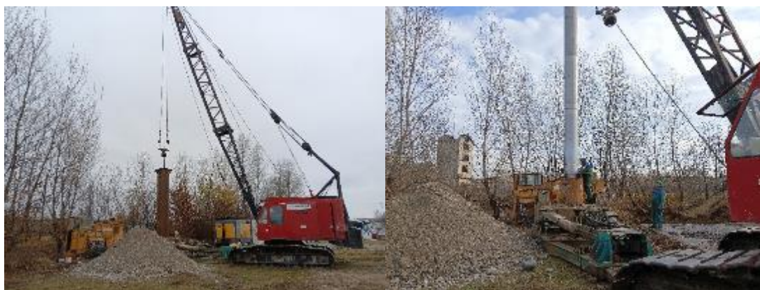
Izdelava vodnjakov za koriščenje geotermalne energije
