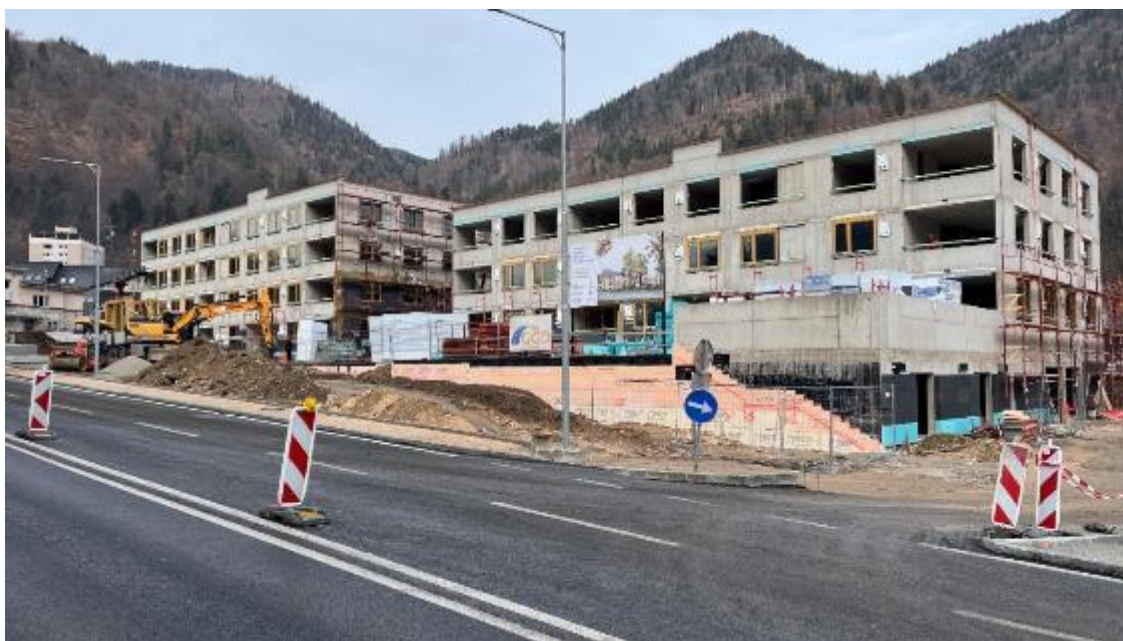
Jesenice, Partizan – gradbišče
