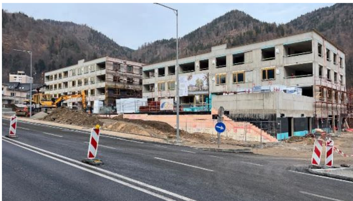
Jesenice, Partizan – gradbišče
