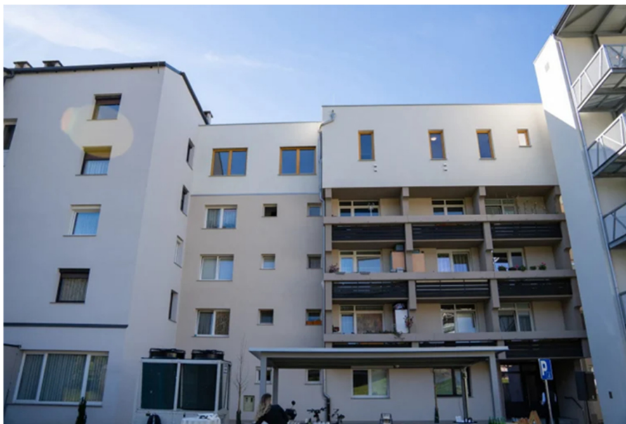
Vir: Koroške novice
